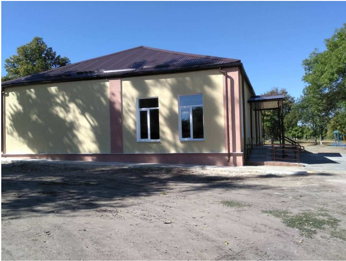
ЦКД с.Рубці після ремонту
